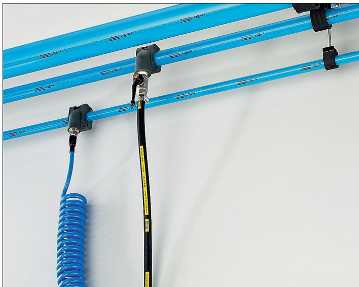
La pose d'un réseau d'air comprimé est aussi de facto affaire de spécialistes en raison des techniques d'assemblage utilisées
