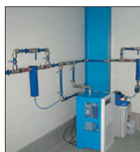
Een optimaal ontwerp met het oog op minimale drukverliezen, aangelegd op een professionele manier, eventueel door gebruik te maken van speciale perslucht netwerksystemen, is aan te bevelen
