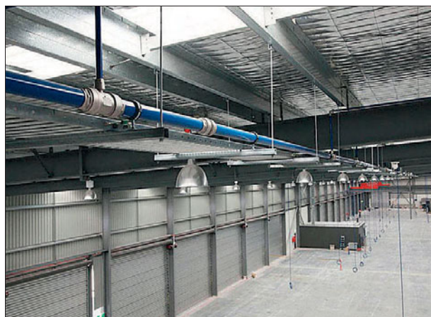
Met het oog op een minimum aan energieverlies vertoont een perslucht netwerk het best zo weinig mogelijk bochten
