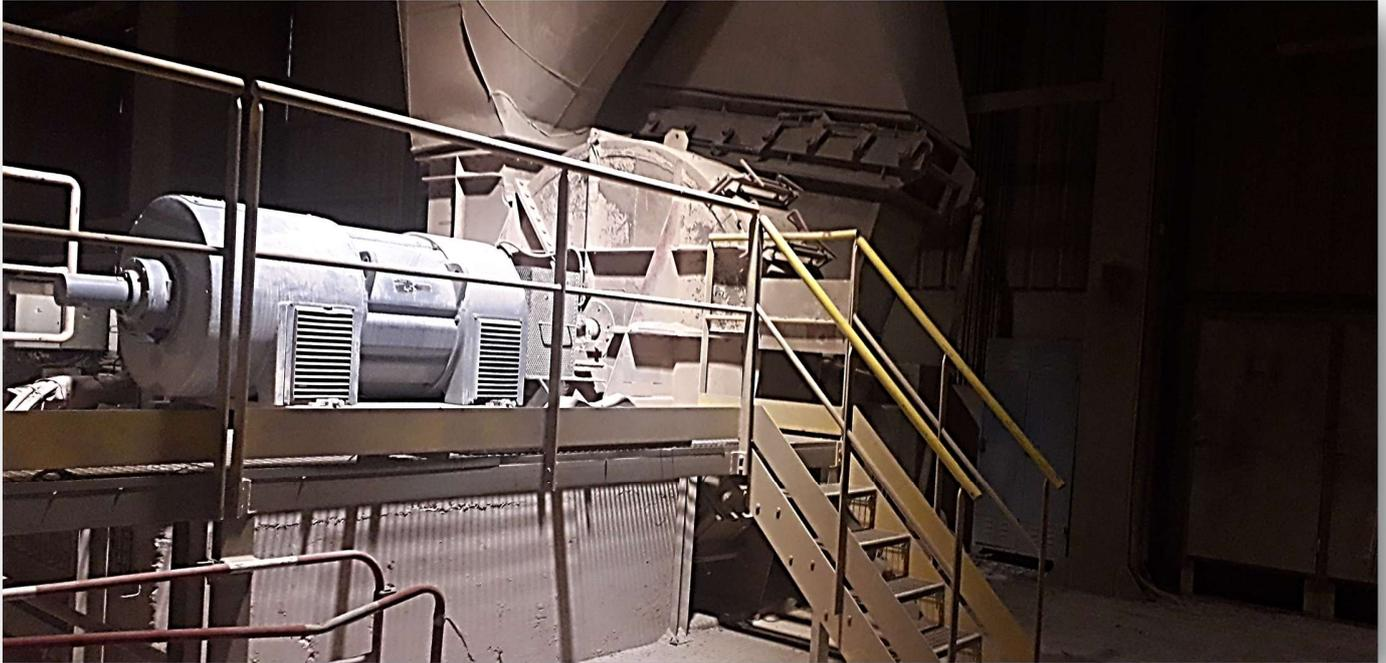
Ventilateur d'extraction de fumées (1480 RPM- 650 kW)
